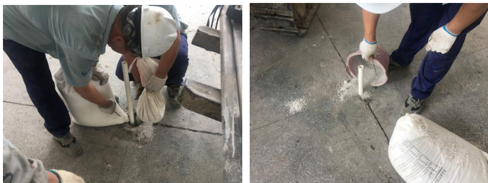
图 5-4 回填石英砂作为地下水滤层（左）和回填膨润球封孔（右）
