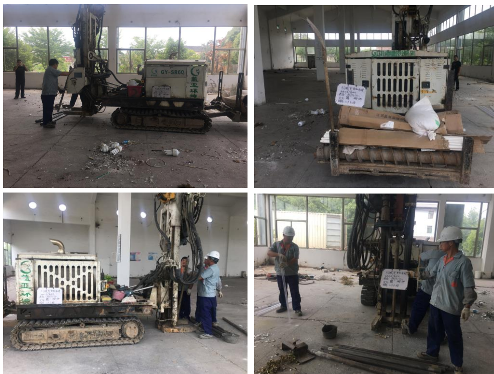
图 5-3 AKDS1 点位土壤样品采集现场照片（顺时针东、南、西、北四个方向）
